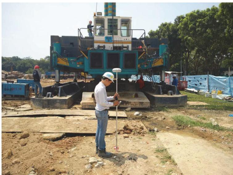
图 30 新加坡北斗高精度接收机应用于施工打桩
