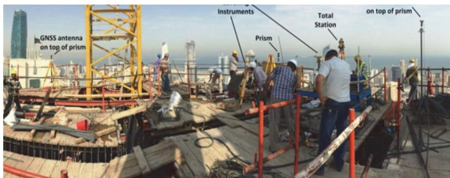
图 26 北斗高精度接收机应用于科威特国家银行总部大楼施工
